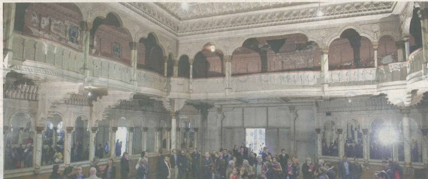
Stuc et bois recouvrent la structure métallique de la magnifique salle de style mauresque. © DOMINIQUE DUCHESNES.
