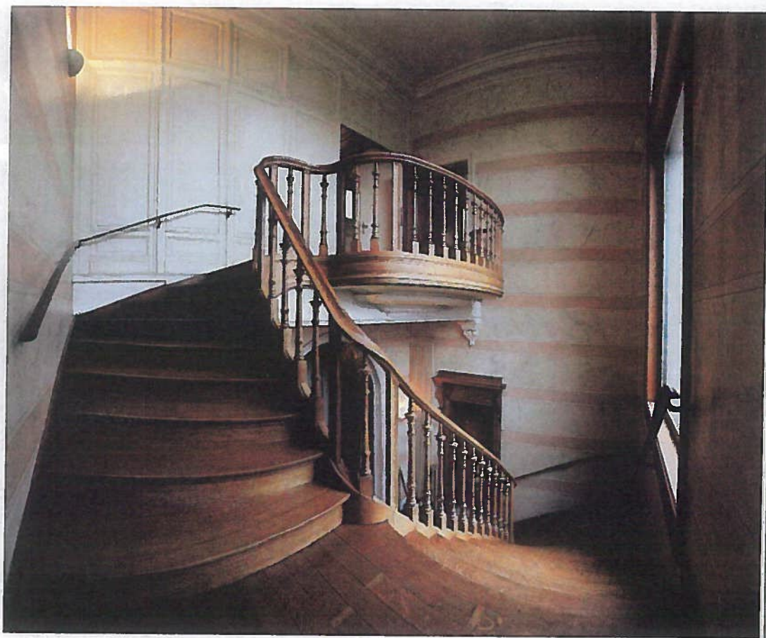
La cage d'escalier après restauration. Tout le démarrage de ce dernier avait disparu et a été minutieusement redessiné. © MARIE-FRANÇOISE PLISSART
