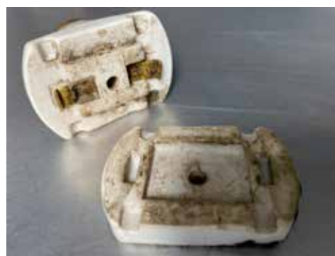
FIG.15A ET 15B Modèle de socket d'ampoule en porcelaine (E27) le plus répandu à l'Ægidium, retrouvé notamment dans le plafond de la salle Mauresque (© MA2, 2019).
