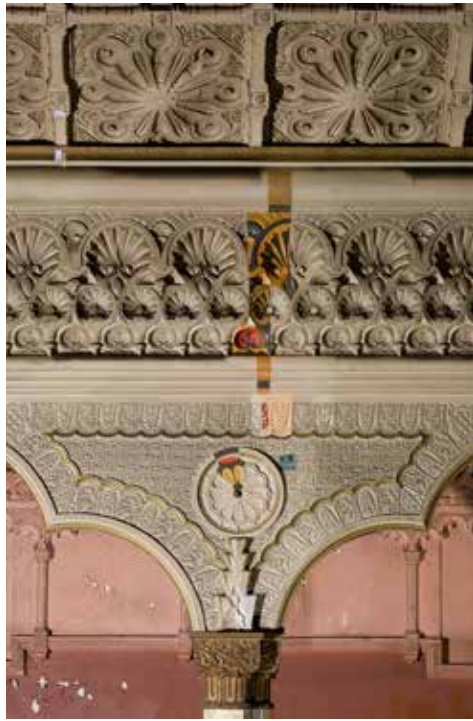
FIG. 13 Salle Mauresque, reconstitution de la polychromie sur base des sondages stratigraphiques ((KIK-IRPA, Bruxelles, cliché X047939, 2015).
