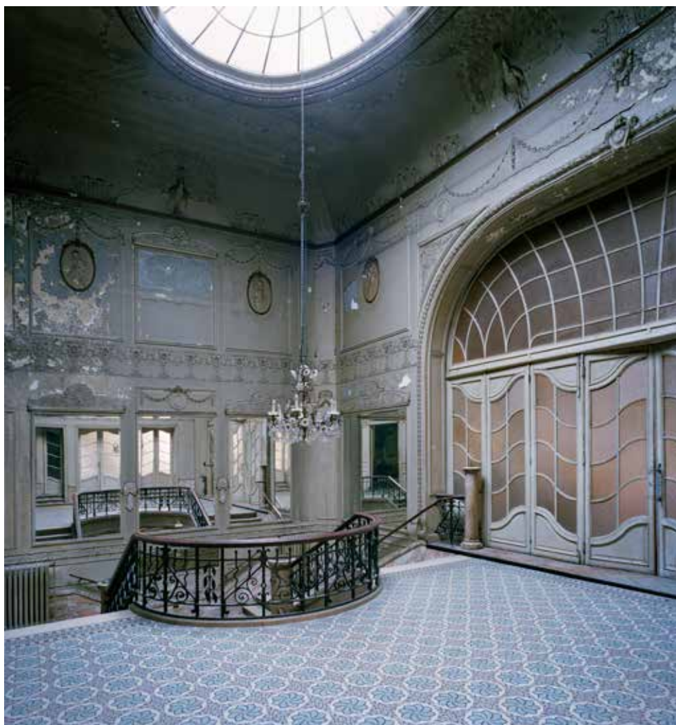
FIG. 8 La cage d'escalier principale (© Marie-Françoise Plissart, 2015).
