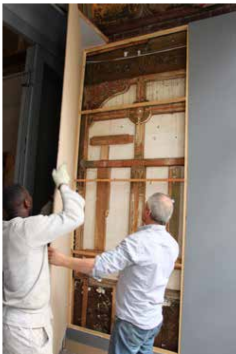
FIG. 6A Démontage dans le couloir d'entrée de l'habillage dissimulant les traces des décors originaux (© MA2, 2013)
