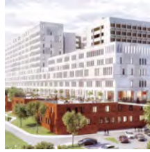
HÔPITAL ERASME En cours
