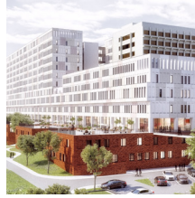
HÔPITAL ERASME En cours
